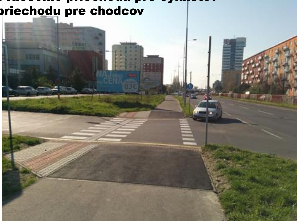
Bajkalská ulica po rekonštrukcii
