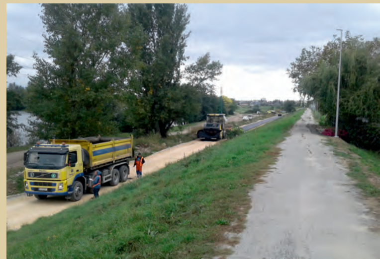
Asfaltovanie cyklotrasy
